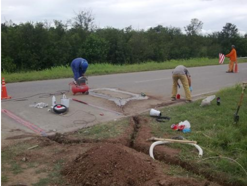
Ilustración 7: instalación de sensores
