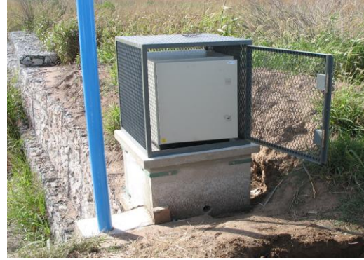
Ilustración 8: bunker del puesto de medición
